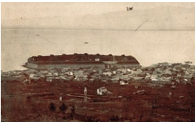
箱館奉行支配諸術調所教授役武田斐三郎が設計した台場跡。新島襄が箱館に来る目的の一つは、武田斐三郎のもとで学ぶことであった。※写真提供/函館市中央図書館
